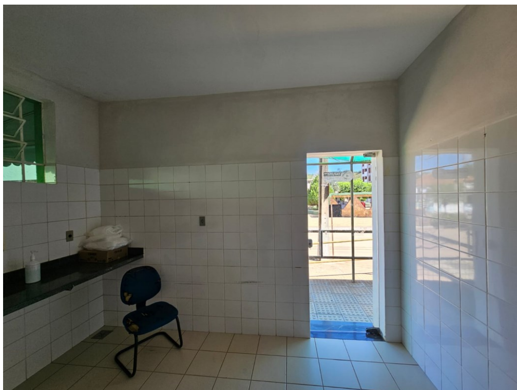
Foto 04: Vista interna da sala que receberá a reforma para implantação do ultrassom;
