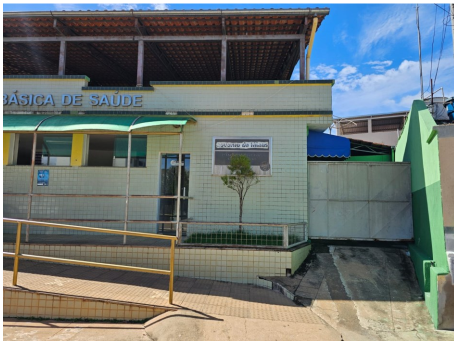
Foto 01: Fachada do imóvel
